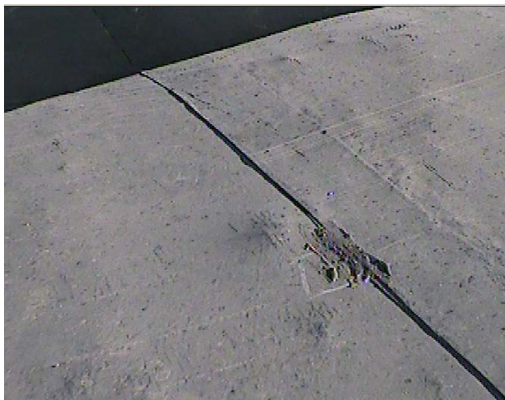
Fig nº 10. Soldadura de vulcanización en EPDM.
