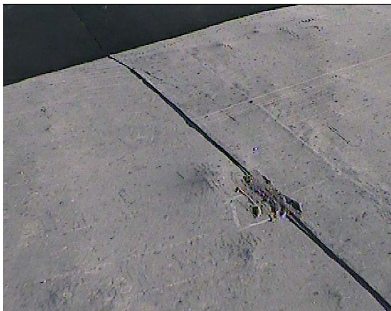
Fig nº 17. Soldadura en EPDM
