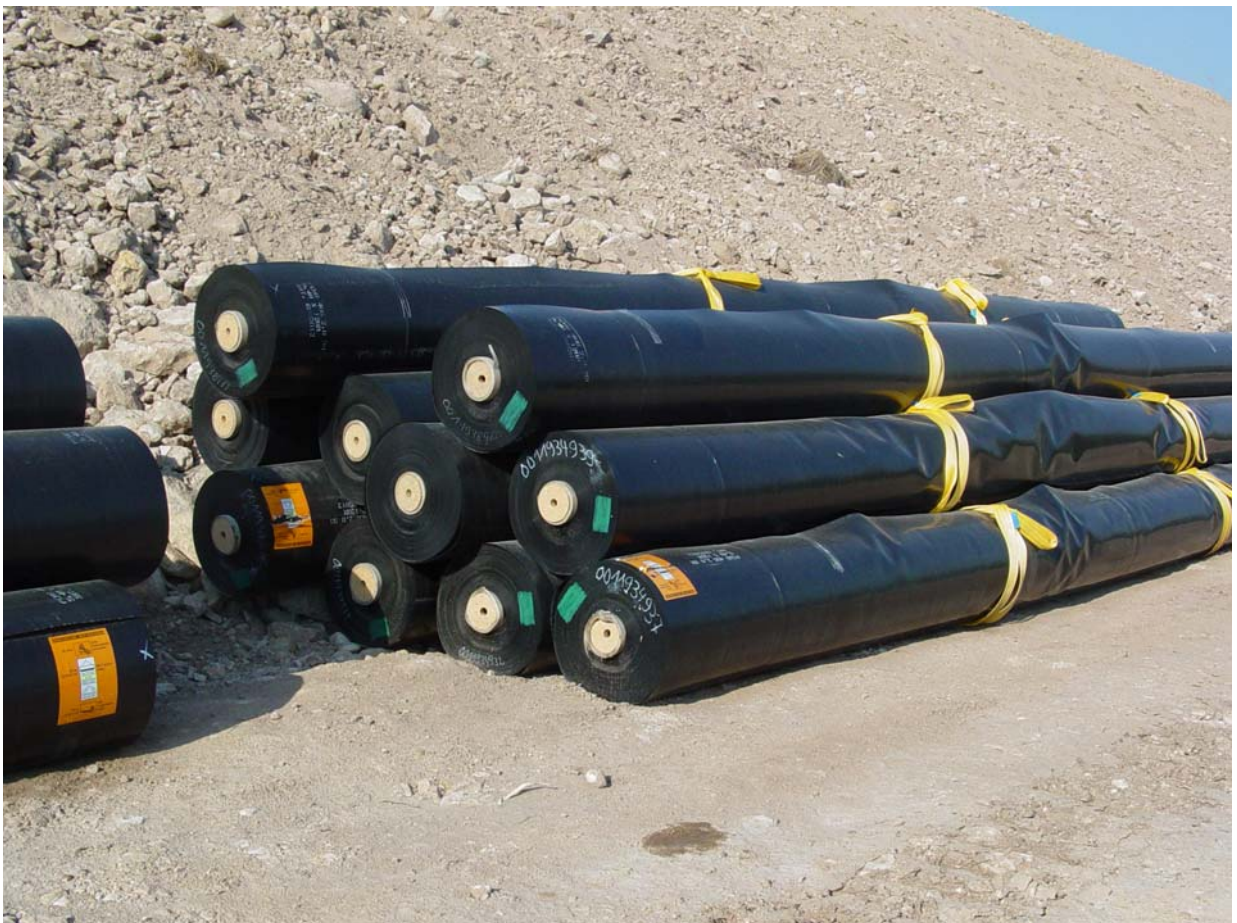
Fig nº 7. Acopio de rollos en obra
