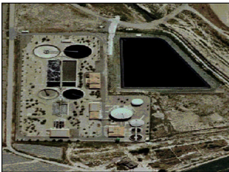
Fig. nº. 1. EDAR de Lorca.
