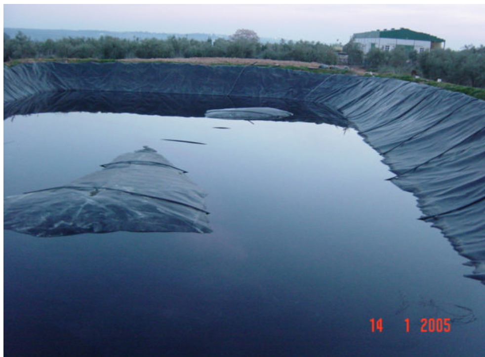
Fig. nº. 3. Cámaras de gases en la solera del vaso.
