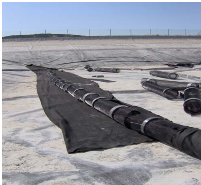
Fig nº 3. Formación de filtro con rodajas de tubos PVC y geored.
