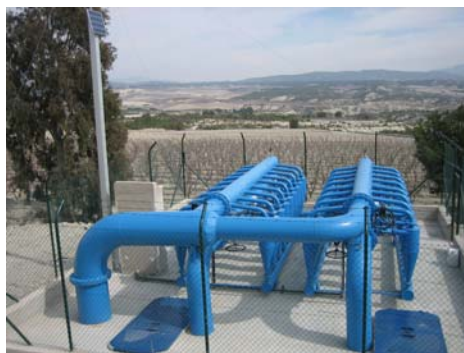
Fig. nº 1. Conjunto de hidrociclones.
