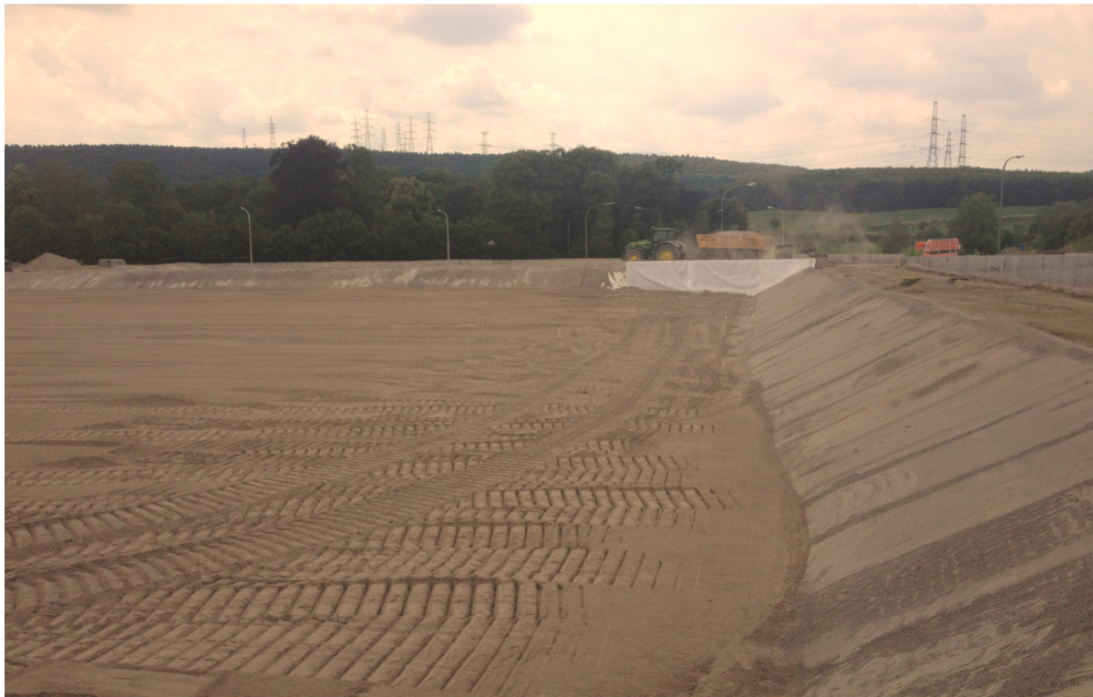
Figura 9: foto del depósito 3 cubierto de arena
