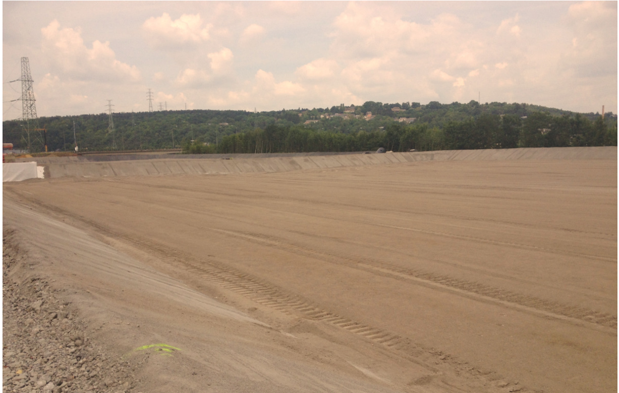
Figura 8: foto del depósito 2 cubierto de arena
